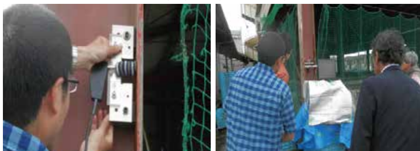
塗膜及び鋼材界面の状況の調査状況
